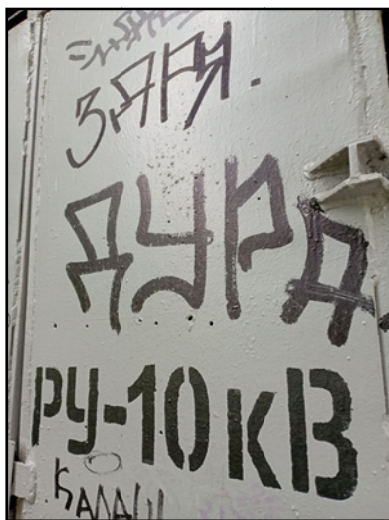
Рис. 3. Граффити на стене хозяйственного корпуса по адресу: ул. Сергея Лазо, 14/2
